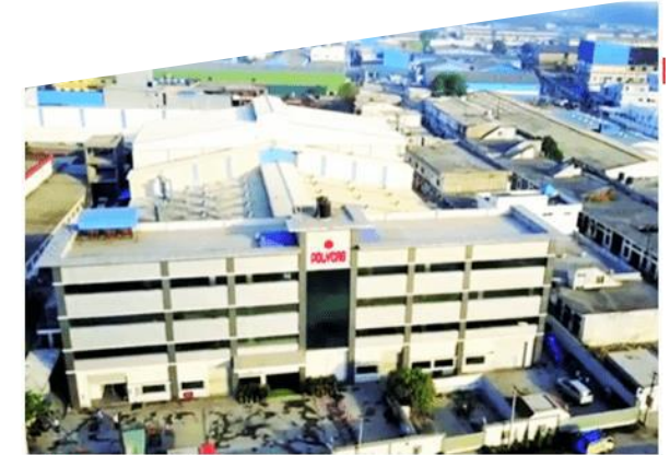
Fan Manufacturing Unit
